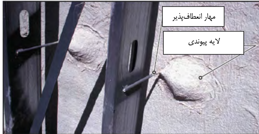
شکل ۶-۳۸ - لایه پیوندی و مهارهای انعطاف‌پذیر
