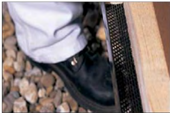
شکل ۶-۶۱- اجرای شبکه توری زیر دیوار
