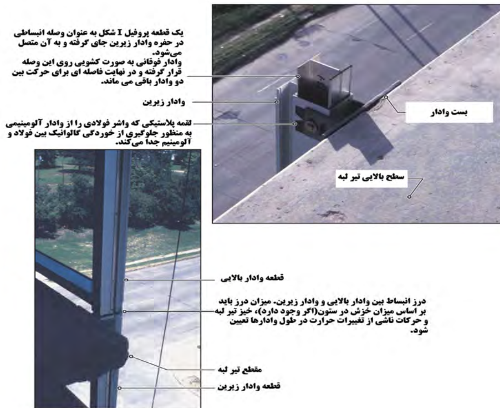
شکل ۸-۸- نمونه اتصال انبساطی بین دو قطعه وادار
