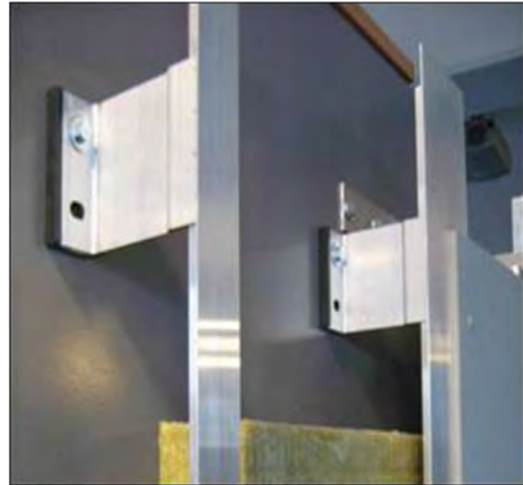
شکل ۶-۴۵- نمونه‌های زیرقاب ساخته‌شده با قطعات آلومینیومی
