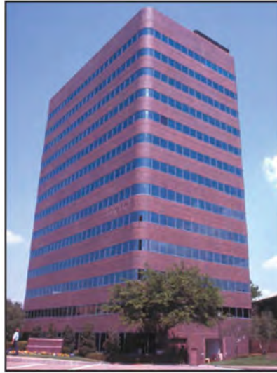
شکل ۵-۲۸- ساختمانی با نما آجری و پنجره‌های پیوسته
