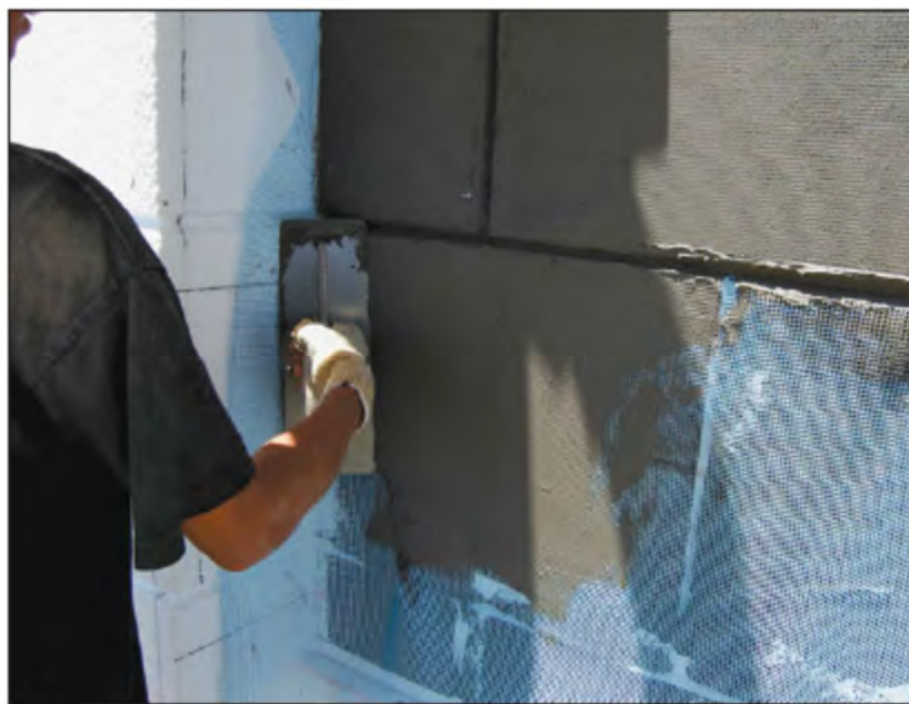
شکل ۶-۱۸- اجرای لایه‌های پوششی
