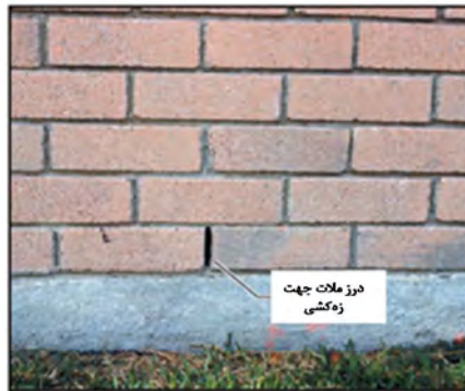
شکل ۵-۱۵- خالی گذاشتن درز ملات جهت زه‌کشی
