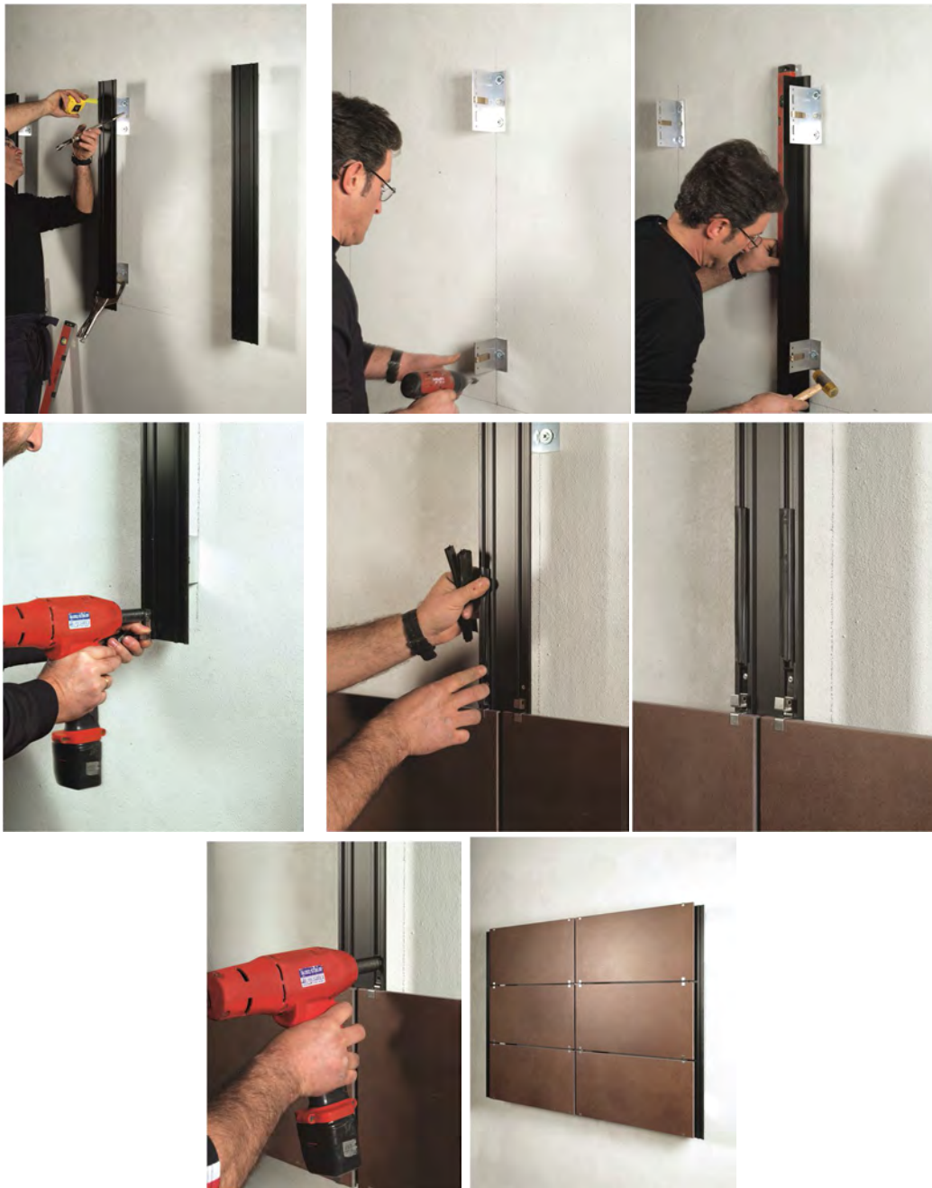
شکل ۷-۲۴- مراحل نصب سیستم نصب نمایان
