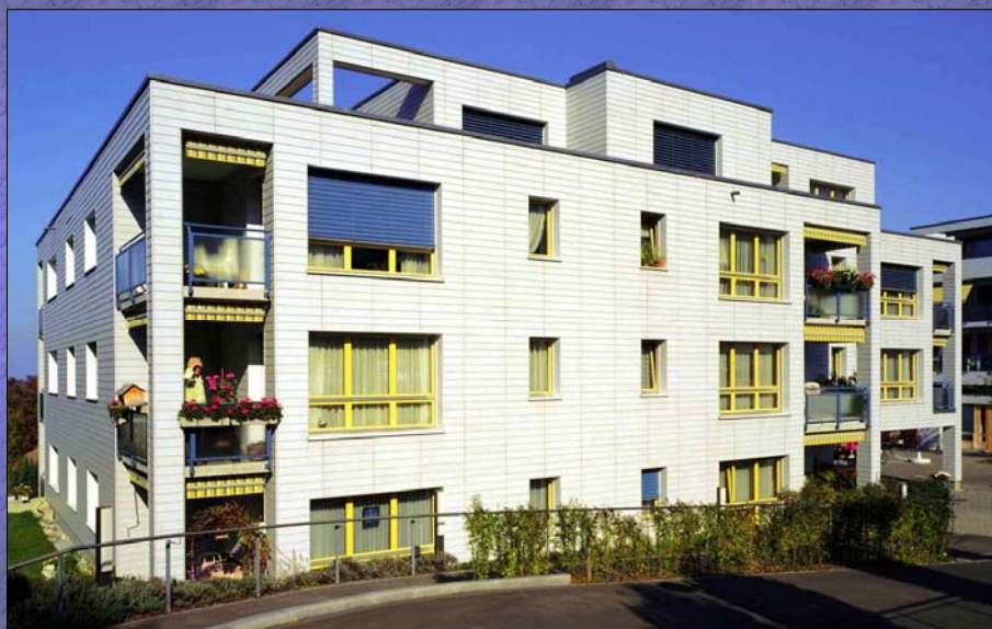
عایق کاری حرارتی دیوارها از خارج با نمای تخته سیمانی
